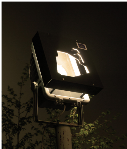
Naravi prijaznejša svetilka (levo), ki omogoča senčenje preletnih odprtih za netopirje na zvoniku in nad vrati cerkve (desno)
